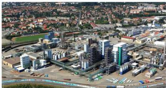
La plateforme industrielle de Pierre-Bénite héberge Arkema et Daikin, qui utilisent ou ont utilisés des PFAS.
