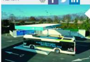
A La Roche-sur-Yon, la station multi-énergies vertes et locales déployée par le Sydev et Vendée énergie alimente les véhicules en hydrogène. D.R.
