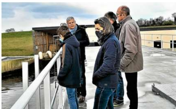
Benoît Dutoit, responsable à LTM, a expliqué le fonctionnement de la nouvelle station d'épuration de Pommeret.
